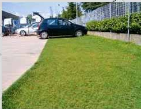
pavimentazione in cls/erba per parcheggi
